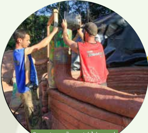
Construção utilizando a técnica de Adobe
