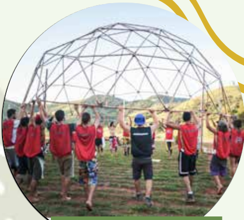
Dinâmica de construção de Geodésica no curso de bioconstrução
